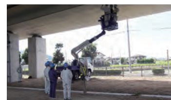
高所作業車による点検を見学中の様子
