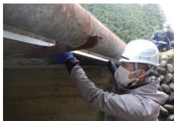
水切り材設置の様子
