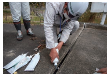
伸縮目地止水材充填の様子
