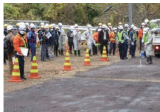
施工中の現場状況
