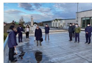
屋上排水のチェックの様子
