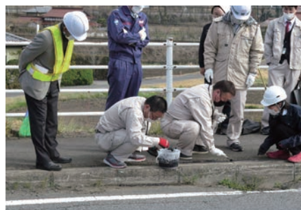
シース技術による施工の様子
