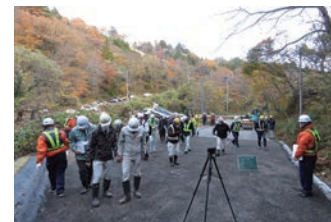
高性能プライムコートによる 碎石の定着を確認
