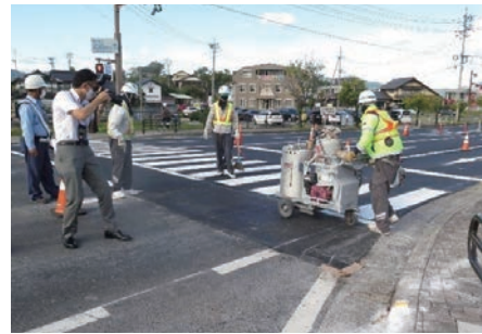
シーズ技術による施工の様子
