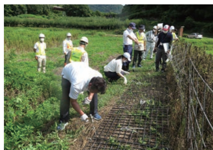
シーズ技術による施工の様子
