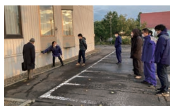
コンクリートのひび割れ確認の様子
