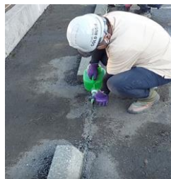
セメント ミルク注入
