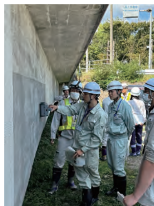
現場実習(コンクリートテスター)の様子
