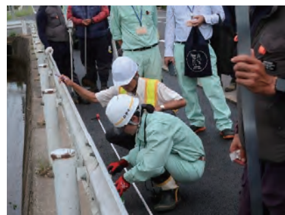
ニーズ提供者による施工体験の様子
