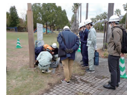
現場実習(非破壊検査手法)の様子
