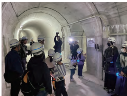
管理用通路の見学の様子
