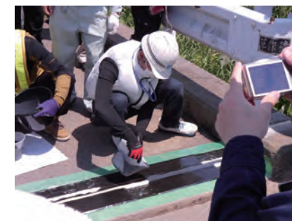
試験施工の様子
